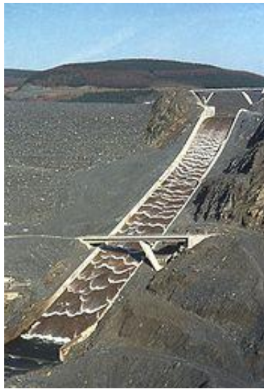
Figura 1. Flujo inclinado que presenta un tren de ondas rodantes en toda su trayectoria 1 .
