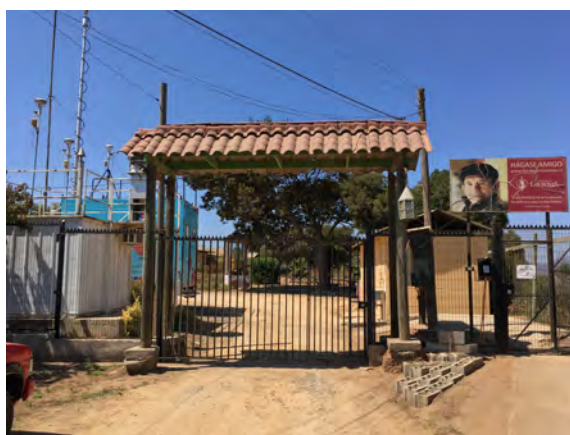
Figura 2.12. Fotografía de la entrada a la estación de monitoreo Ventanas
