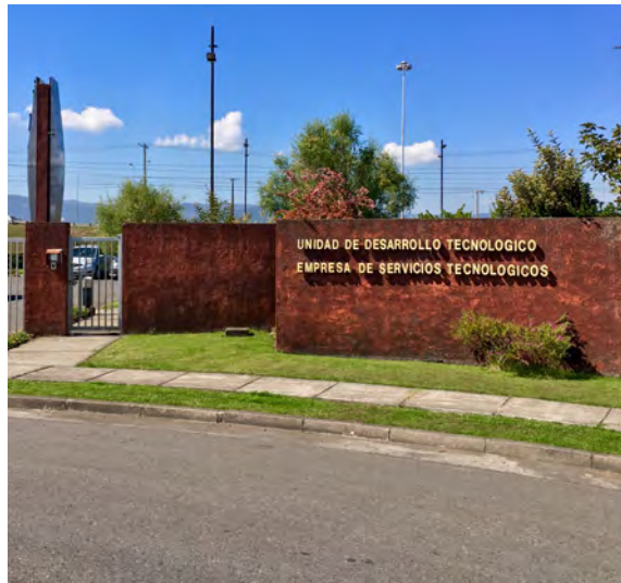
Figura 2.17. Estación de monitoreo UDT donde se instaló el equipo discreto de material particulado
