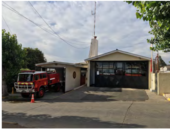
Figura 2.8. Fotografía de la entrada del cuartel de bomberos donde se instaló el KFG.
